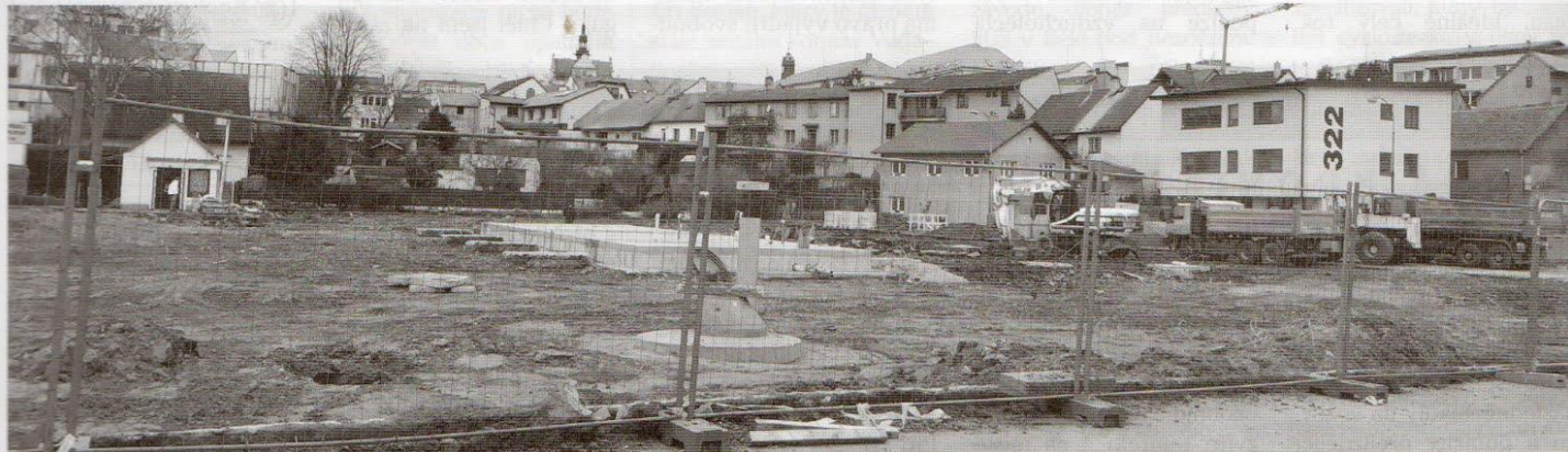
Dokumentujeme pravidelně výstavbu nového autobusového nádraží v Sedlčanech. Situace na stavbě 18. března. Foto: Hana Pechačová
